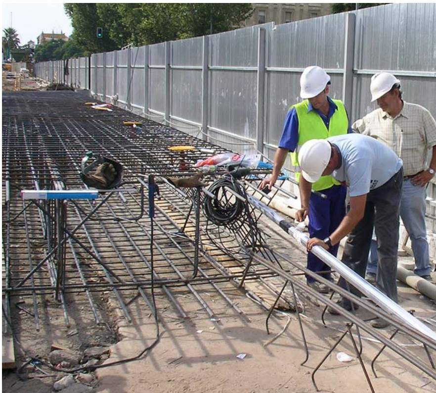
Figura 2. Instalación de la tubería inclinométrica en la jaula de armadura de las pantallas
