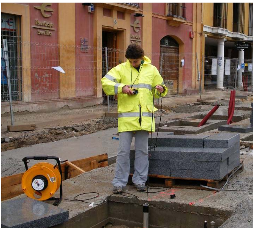
Figura 3. Toma de lecturas inclinométricas en campo con el sensor
